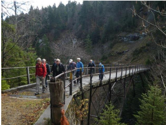
Auf der Fallbachbrücke
